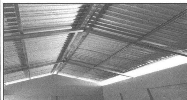
Foto 3: Sustitución de costaneras
