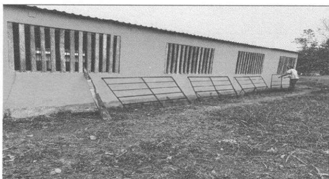
Foto 3: Modulo 3 momento de la colocación de los ventanales de madera a metal.
