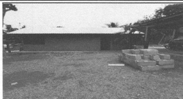
Foto 2: Sustitución de techo modulo 4, con láminas troqueladas.
