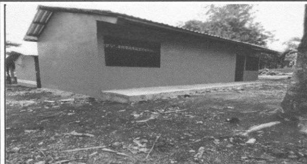
Foto 1: Modulo 4 de esa manera se quedó, la remodelación, piso, ventana, pintura,
